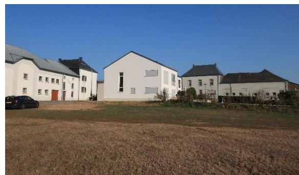
vorhandener Ortsrand von Nord-Westen her betrachtet
