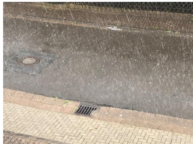
Abbildung 80: Wasser schießt oben über normalen Einlauf drüber, bei Bergeinlauf unten nicht
