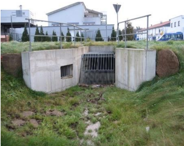
Abbildung 77: Beispiel großzügig dimensioniertes Einlaufbauwerk Quelle: Stadt Karlsruhe
