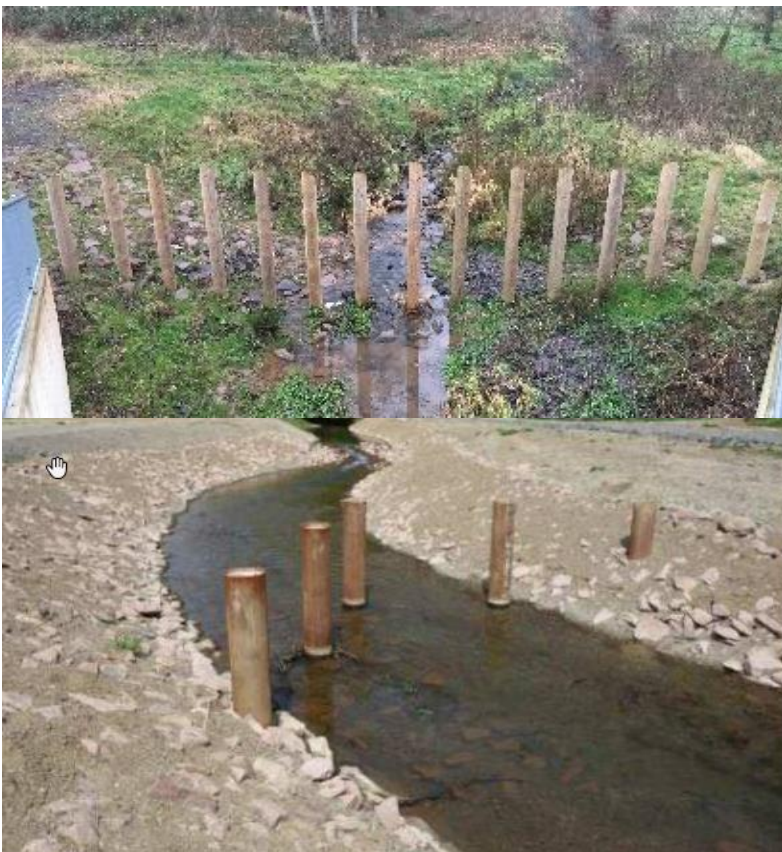
Abbildung 47: Sohlrechen/Treibstoffrückhalt im Sturzflutentstehungsgebiet [17], [18]
