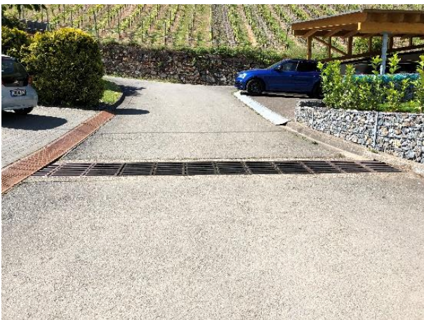
Abbildung 84: Beispiel breite Überfahrbare Entwässerungsrinne mit breiten Schlitzten
