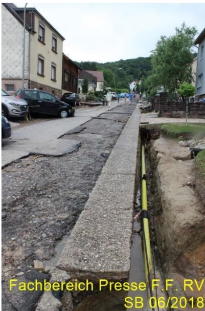
Abbildung 21: Freigespülte Gasleitung
