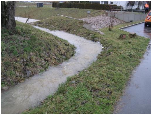
Abbildung 75: Beispiel großzügig dimensionierter Leitgraben Quelle: Wald&Corbe
