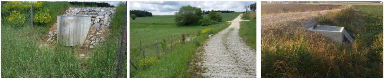
Abbildung 54: Beispielfotos Rückhalteräume durch Erhöhung Feldwege aus PPT Sandra Corbeck 2017, Neue Wege zum Boden- und Gewässerschutz, Bay. Verwaltung für ländliche Entwicklung
