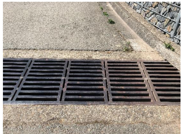
Abbildung 85: Beispiel breite Überfahrbare Entwässerungsrinne mit breiten Schlitzten
