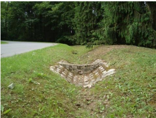
Abbildung 58: Gutes Beispiel – Graben mit Querbauwerk zur Optimierung, Archiv eepi
