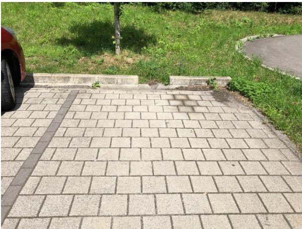
Abbildung 82: Beispiel Ableitung Wasser von Parkflächen in Freiflächen
